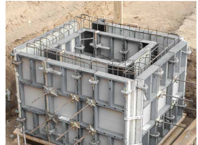
Mit Innen- und Außenecken sowie mit stufenlos verstellbaren Gelenkecken werden alle Ecken von 0 bis 180 Grad einfach geschalt.
